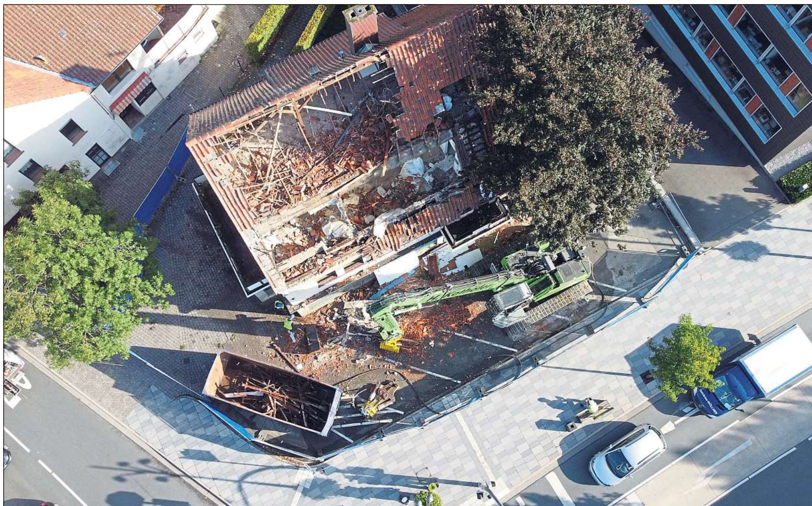
Tschüss, altes Haus: Bis Ende der Woche wird vom Kopshoffschen Haus auf der Ecke von Paderborner Straße und Hauptstraße nicht mehr viel übrig sein. Die Stadt lässt das Gebäude abreißen. Foto: Martin Wanders
