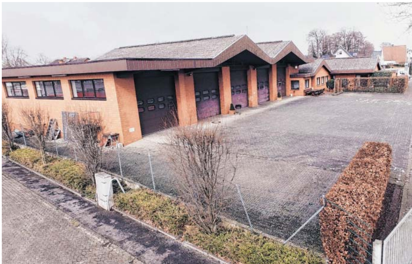
Soll abgerissen werden: Das Feuerwehrgerätehaus in Kaunitz ist zu klein geworden und wird durch einen Neubau ersetzt. Doch schon vor dem ersten Spatenstich sind die Kosten um 25 Prozent gestiegen.
