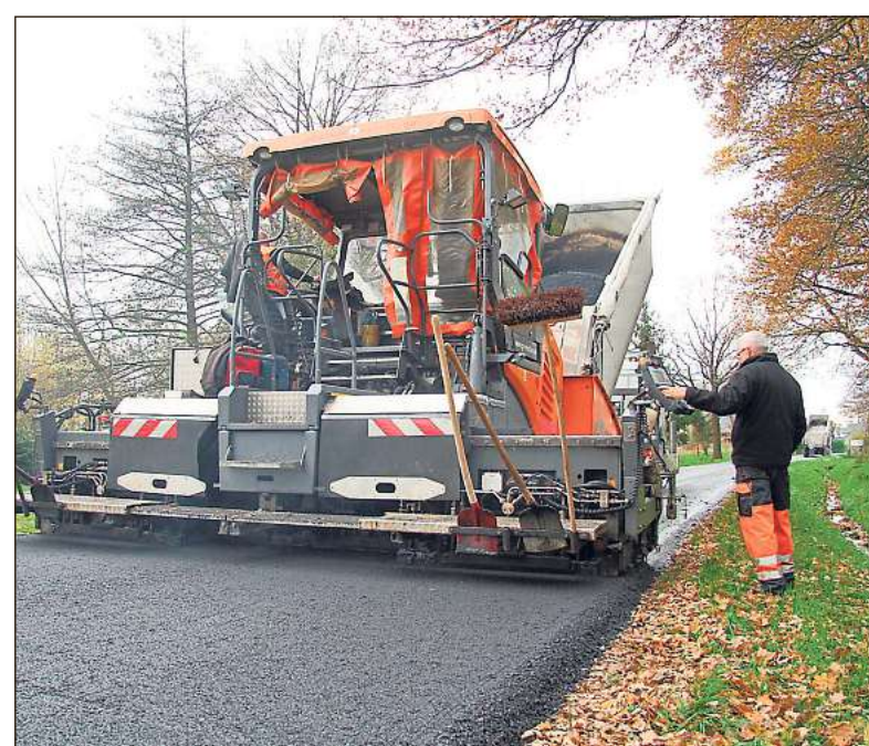
Die Kreisstraße 42 (Kaunitzer/Westerwieher Straße) ist vom heutigen Mittwoch an wieder für den Verkehr frei. Die letzten Deckenarbeiten sind abgeschlossen. Im Frühjahr werden Markierungen aufgetragen.
