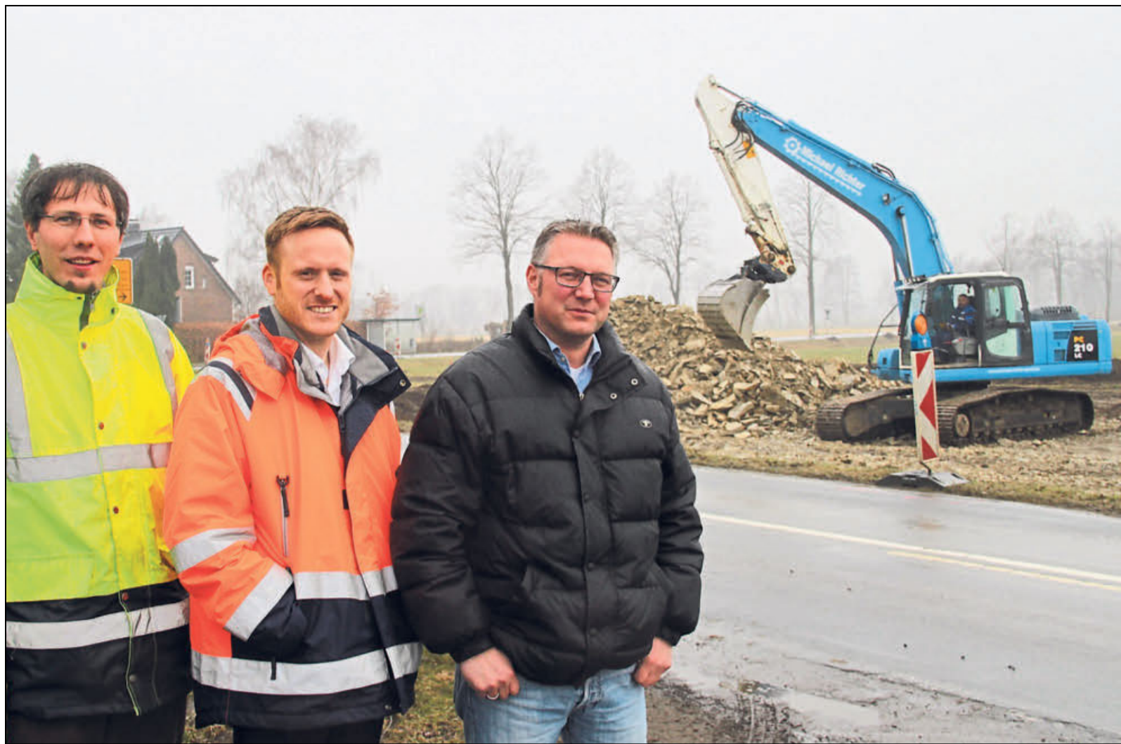
Begleiten die Bauarbeiten an der Österwieher und Neuenkirchener Straße (von links): Matthias Müller (Michael Richter Tiefbau), Henrik Egeler und Timo Kohl (beide Kreis Gütersloh, Abteilung Tiefbau). Die entscheidende Phase steht bevor. Foto: Kerstin Eigendorf
