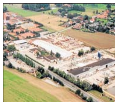
Das Betonwerk im Jahr 2000 aus der Vogelperspektive.
