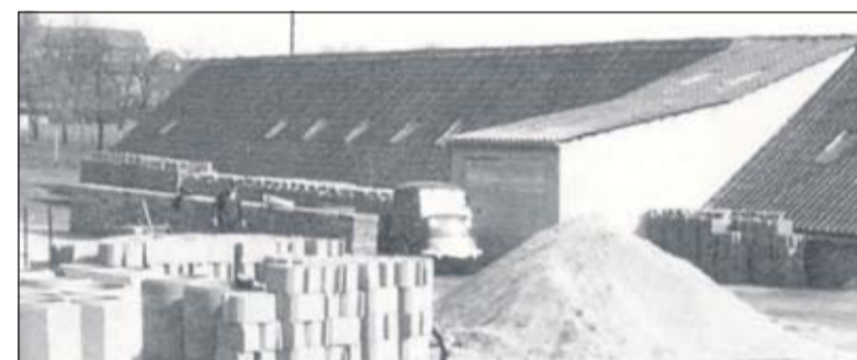
Dieses Bild aus den 60er Jahren zeigt die erste Produktionshalle, die heute mehr als 100 Meter lang ist.
