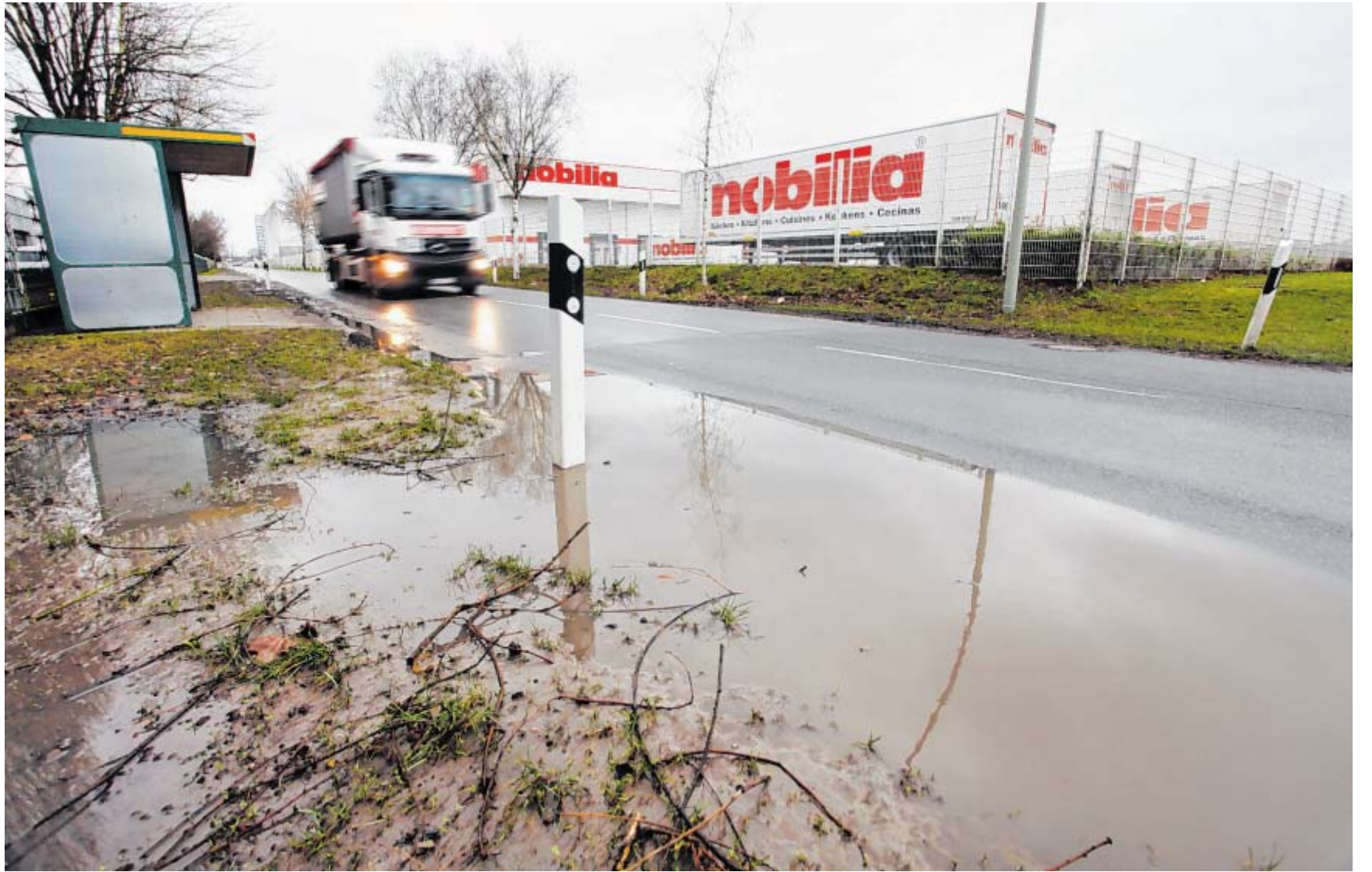
Noch eine Baustraße: Die Daimlerstraße im Kaunitzer Gewerbegebiet Kapellenweg soll im kommenden Jahr ausgebaut werden. Die Stadt rechnet mit Baukosten von 1,2 Millionen Euro. Zuvor soll aber das Ende der Bauarbeiten bei Nobilia abgewartet werden. Das Unternehmen will ein Parkhaus errichten. FOTO: ROLAND THÖRING
