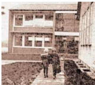
12. Oktober 1967: Die NW veröffentlichte dieses Bild, das hinter dem alten Schulgebäude an der Thaddäusstraße (heute Kita) einen Teil des Neubaus der St.-Georg-Schule zeigt. FOTO: ARCHIV
