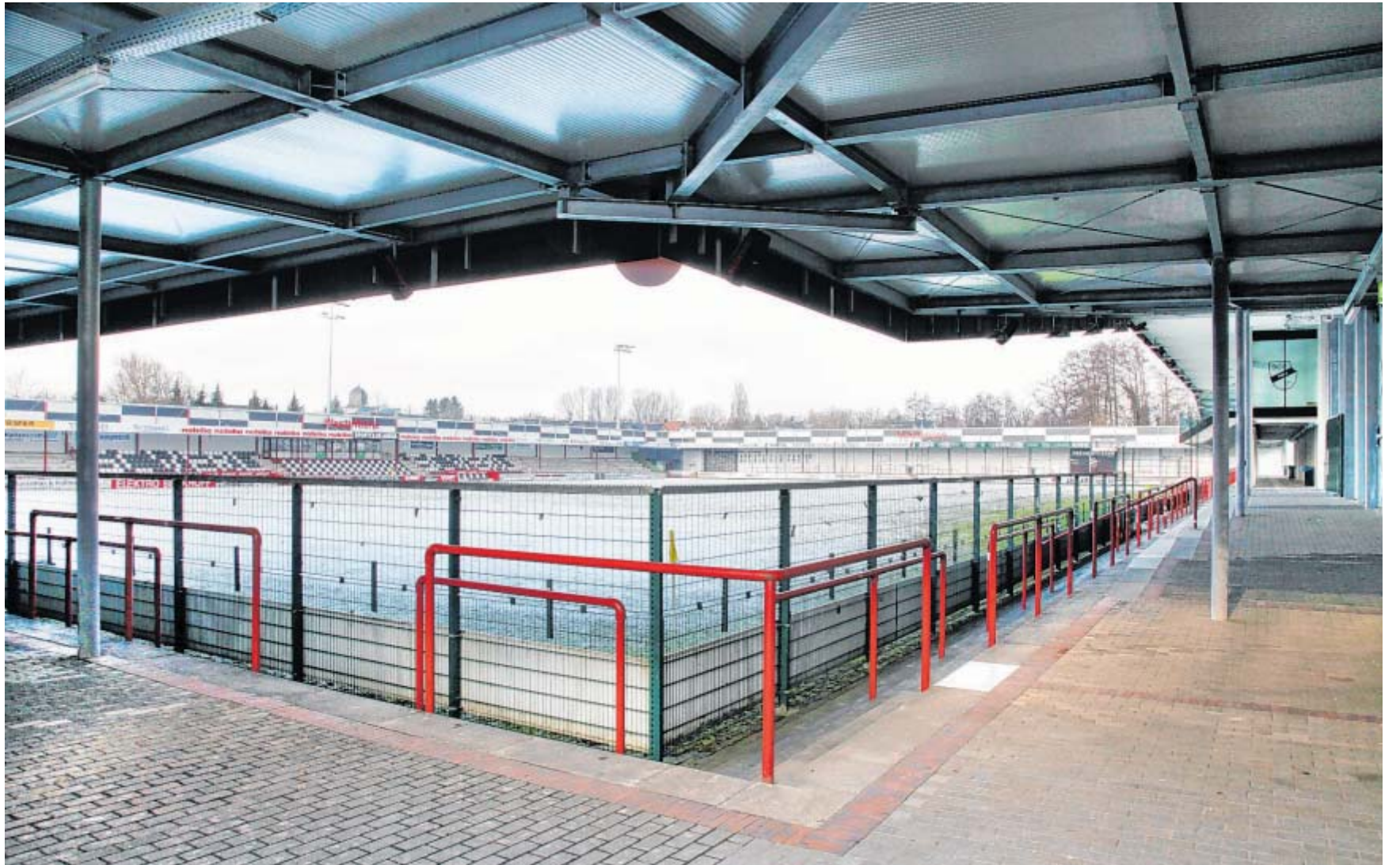
Vollständig eingehaust: So präsentiert sich die Sportclub Arena des SC Verl an der Poststraße. Dennoch halten zwei Nachbarn an ihrer Klage gegen die Baugenehmigung für das Stadion fest. Jetzt will das Verwaltungsgericht einen Verhandlungstermin innerhalb der nächsten sechs Monate anberaumen. FOTOS: ROLAND THÖRING
