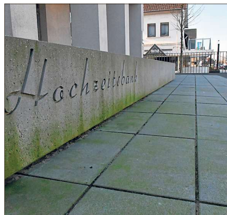
Der Platz vor dem Standesamt soll leichter von Konfetti und Reis gereinigt werden können. Derzeit bleibt das, was die Gratulanten der Brautpaare werfen, in den Fugen stecken. Um diese verfüllen zu lassen, nimmt die Stadt im Verlauf des Jahres 15 000 Euro in die Hand. Einer von vielen vergleichsweise kleineren Posten im städtischen Haushalt. Bild: Tschackert
