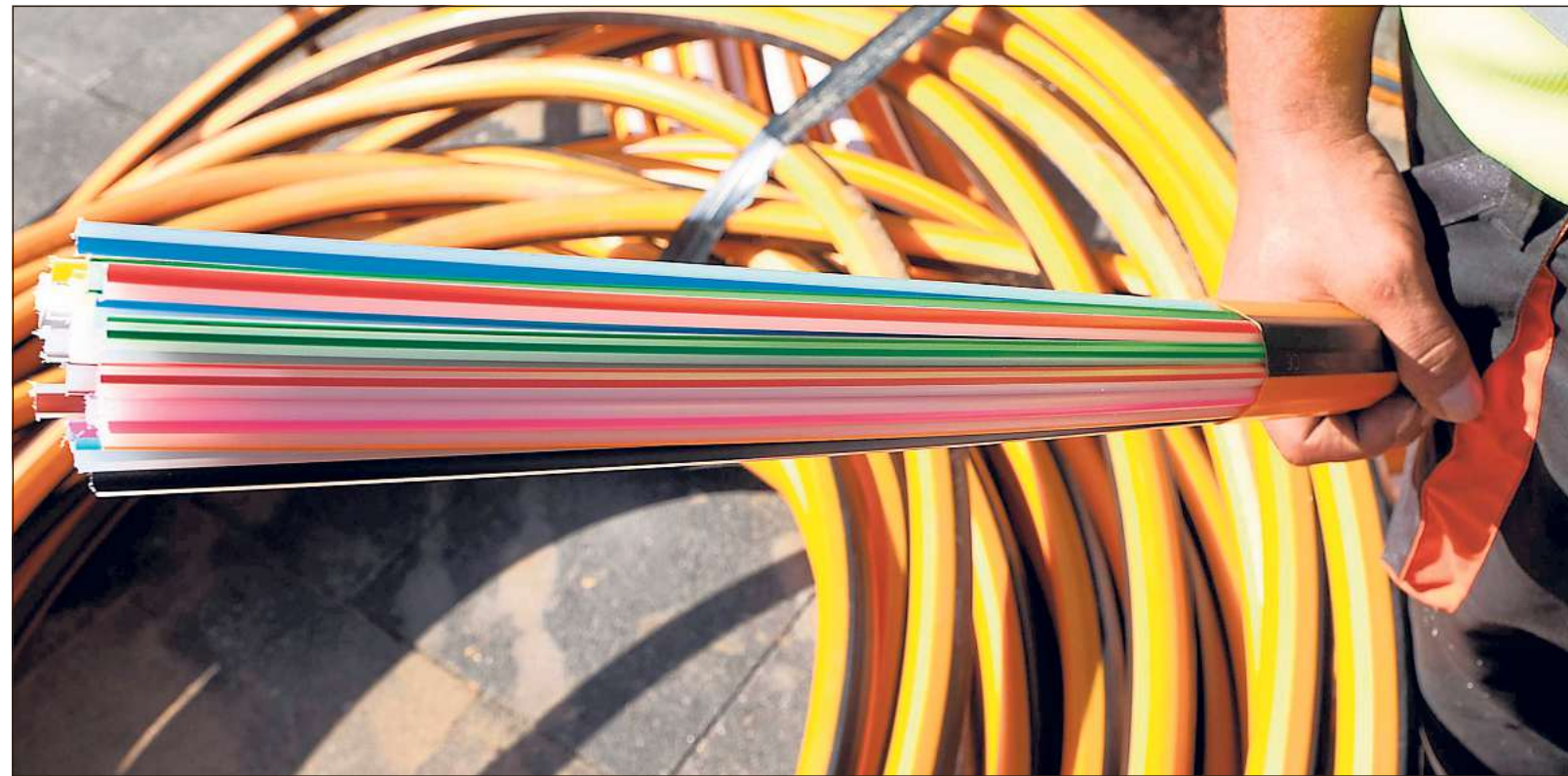
Glasfaserleitungen bis an die Hauswand: Das ist das Ziel der Stadtverwaltung. Fördergelder sollen genutzt werden, um im Außenbereich tätig zu werden. Bilder: Steinecke
